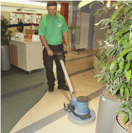
Vorarbeiter Klaus-Dieter Kunick arbeitet eine Sprayemulsion mit einer Einscheibenmaschine ein. Abschließend wird der Fußboden poliert.
