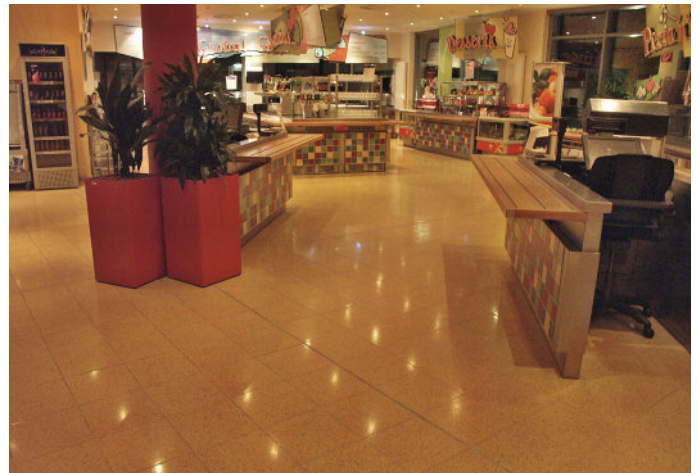
Verpflegungsbereich: Nach dem Twistern erstrahlen die Betonwerksteinfliesen in altem Glanz.
